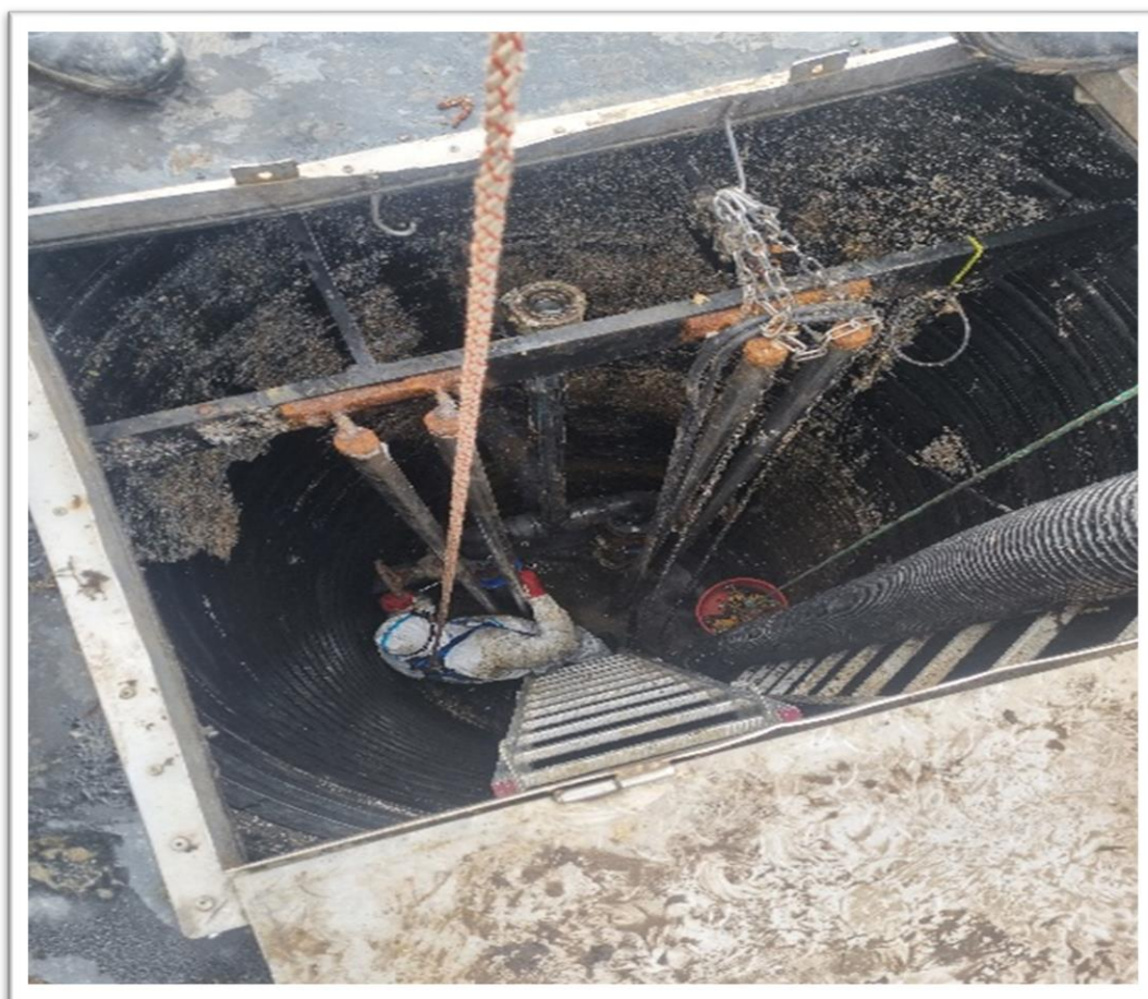
Prace na studni głębinowej, przepompowni ścieków, sieci wodociągowej
