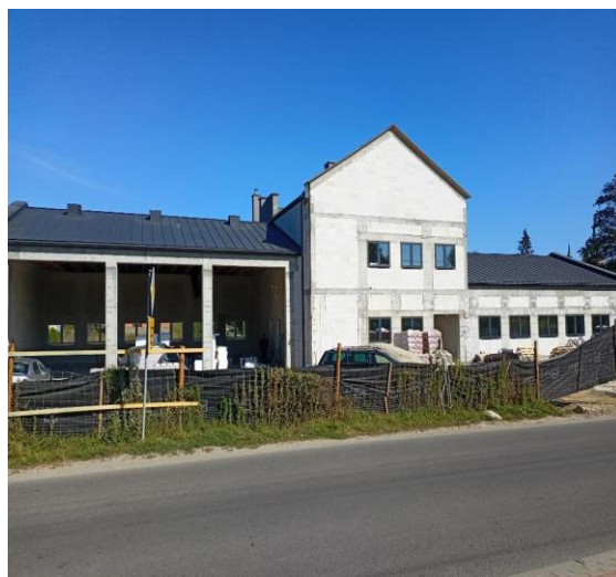
Stan budowy we wrześniu 2022 r.
