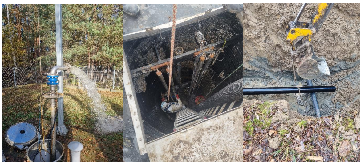
Prace na studni głębinowej, przepompowni ścieków, sieci wodociągowej
