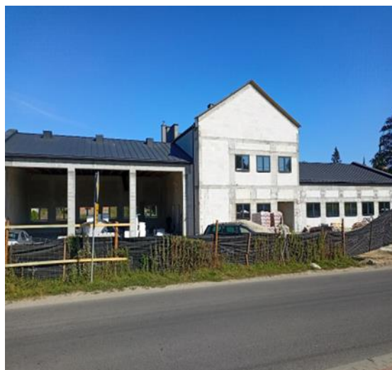
Stan budowy we wrześniu 2022 r.
